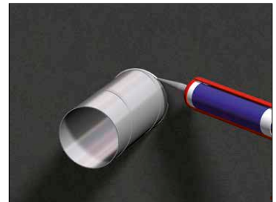
Fuging rundt gjennomføringer
